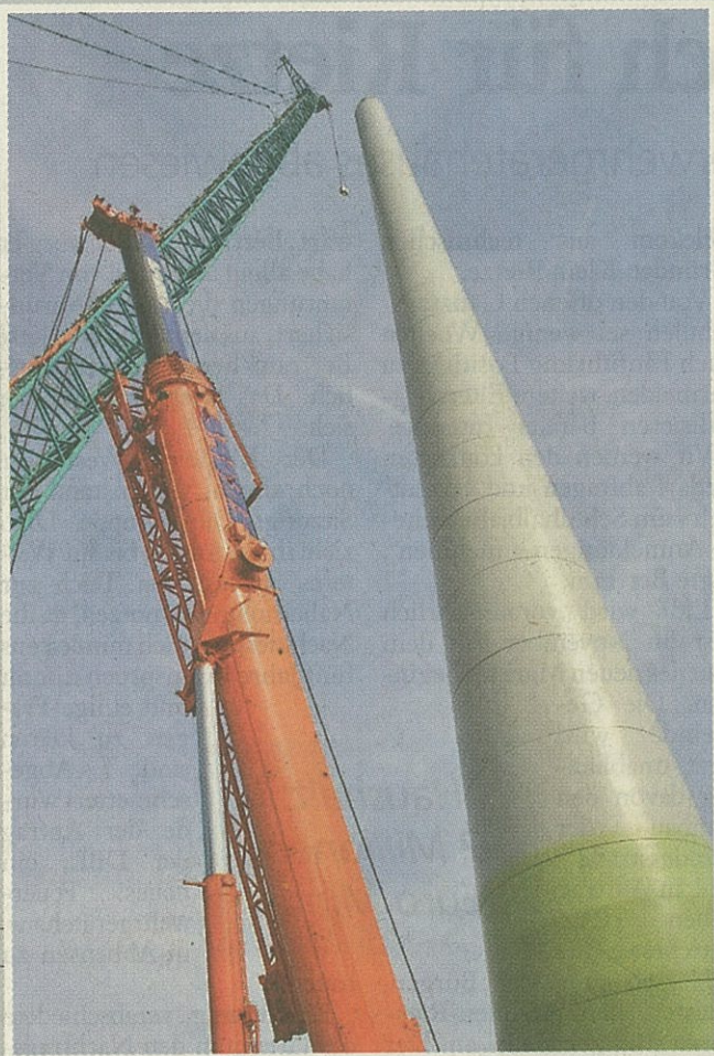
Windrad-Giganten: In Mehrum (großes Bild im Hintergrund) hat der Bau gerade erst begonnen, in Ohlum (oben) ist der Mast schon so gut wie fertig. sur/2
