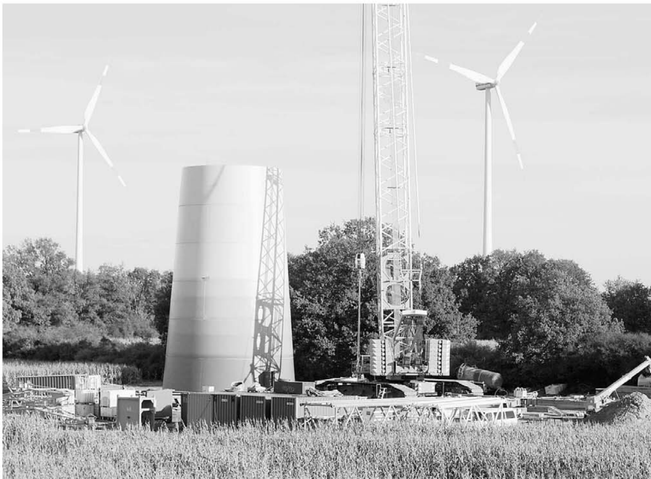
Sieht ein bisschen wie ein kleiner Atommeiler aus, wird aber ein Windrad: An der A 24 baut die Firma Windstrom eine neue Anlage. FOTO: VOGEL
