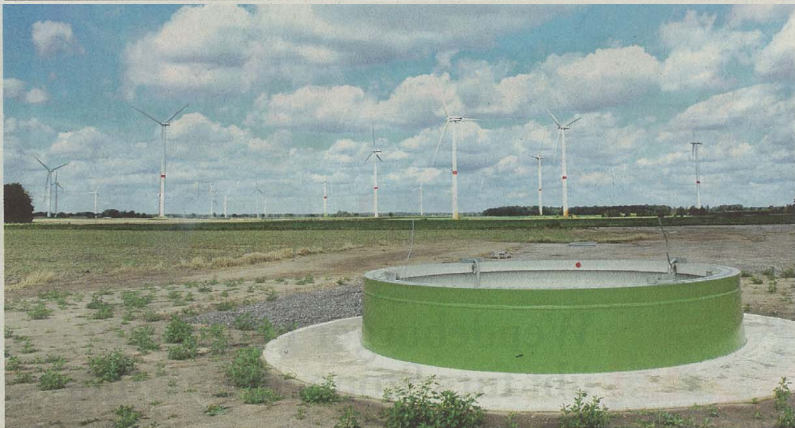
Der Windpark bei Oelers wird um zwei neue Windkraftanlagen erweitert. Im Vordergrund ist der neue Sockel einer Anlage zu sehen.
