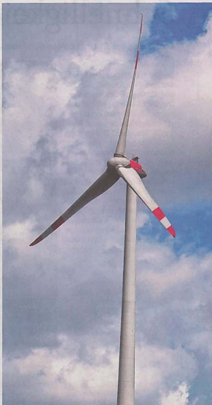
Maximale Höhe: 185 Meter. Die Windmühlen messen bis zur Rortornabe 135 Meter und haben einen Rotor von 101 Metern Durchmesser. KÜHL
