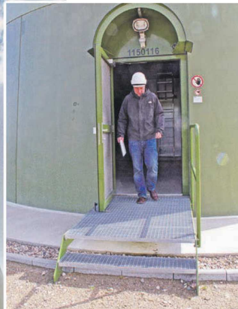
Ingo Lang vom Unternehmen WindStrom hat den Bau der Anlagen geleitet
