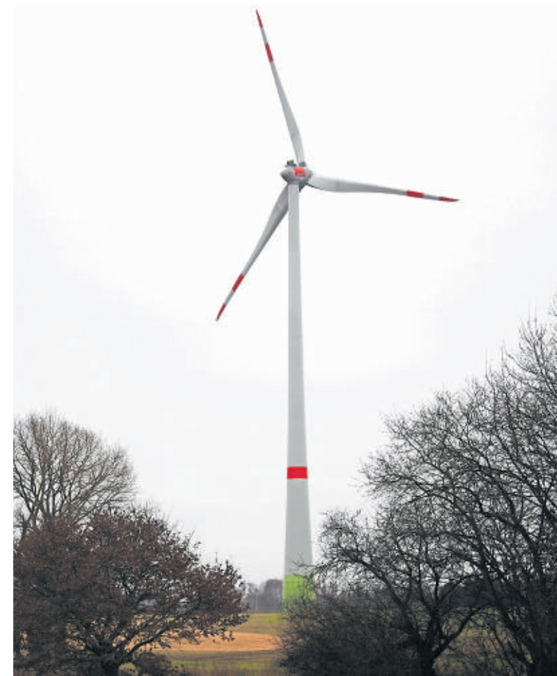
In Daensen werden zwei 193 Meter hohe Anlagen vom Typ Enercon E-115 errichtet; das Foto zeigt eine baugleiche Anlage in Immenbeck. Fotos Vasel
