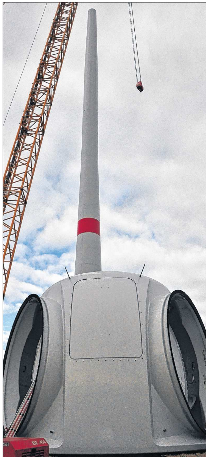
Diese Nabe, an der die Flügel einer Windkraftanlage befestigt werden, wartet im Windpark Lüge/Thüritz darauf, in eine Höhe von 141 Metern gehievt zu werden.
