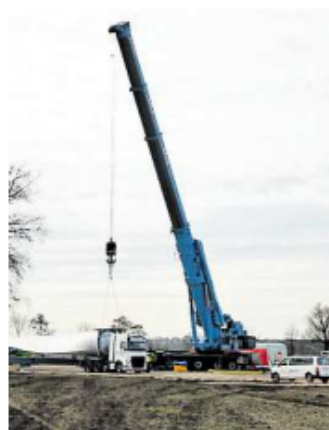
Ein Kran hievt das angelieferte Windradteil von einem Transporter. FOTO: SCHILLER
