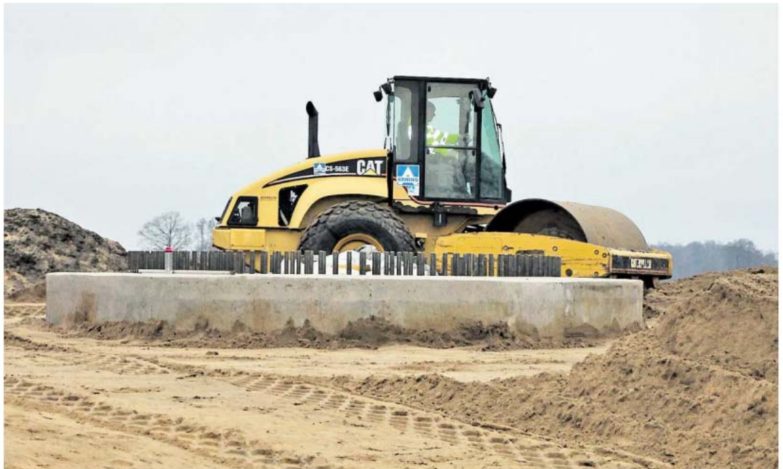
Baggerfahrer Hubert Ribbert verfestigt mit einer Walze den Boden, den er an das Fundament für eines der Windräder geschoben hat.
